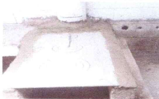
Foto 4: Reparación de la plancha ya terminada
