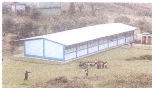
Foto1: Pintura de las aulas y edificio TERMINADO.
