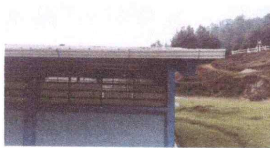
Foto 2: Canales y bajadas de agua terminado
